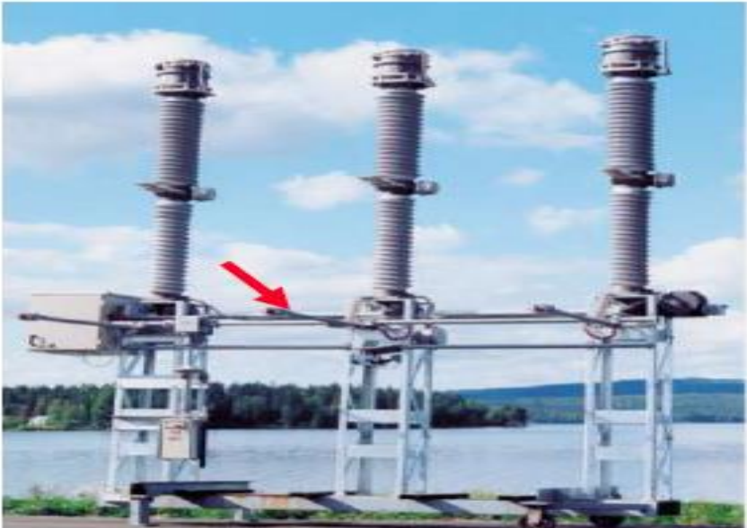
Interruptor cerrado/Cuchilla abierta
