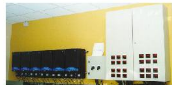
Instalación de los inversores
