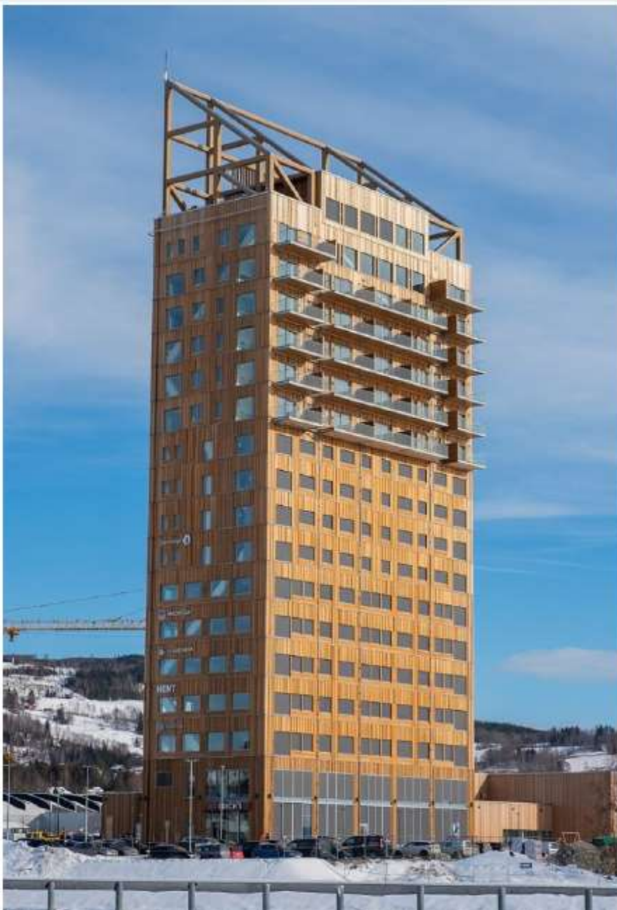
Torre Mjøsa, Brumunddal, Noruega.
